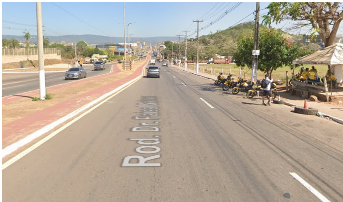
Figura 1 – ATR07004 - Rodovia PA 275, KM 61+900
