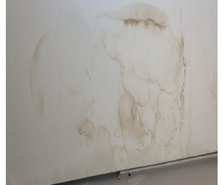
12-Corredor de acesso às salas
