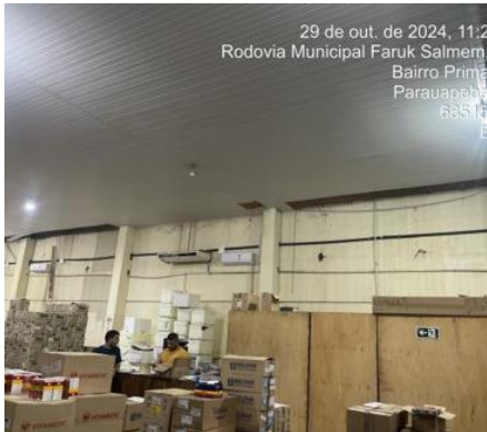
22-Pintura Centro de Abast. Farmacêutico
