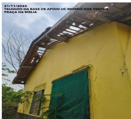
8-Telhado base de apoio Praça da Bíblia
