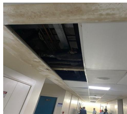
33-Sistema de refrigeração HGV
