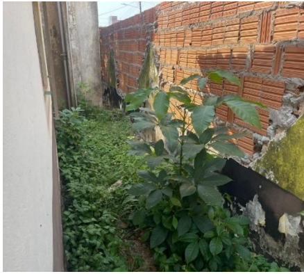
7-Forro interno Prédio Antigo Rua 09
