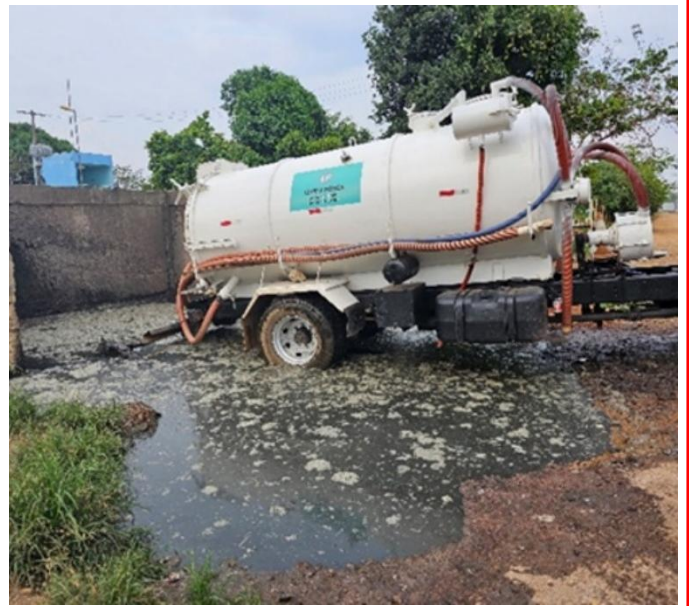
3- Descarte de efluentes de fossa séptica na ETE WTorres
