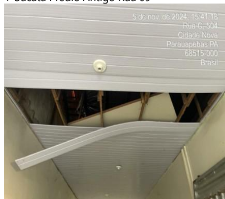
4-Forro interno Prédio Antigo Rua 09
