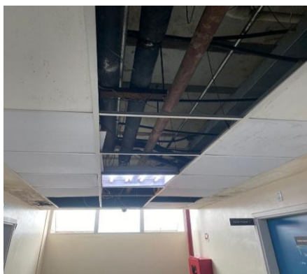
34-Sistema de refrigeração HGV
