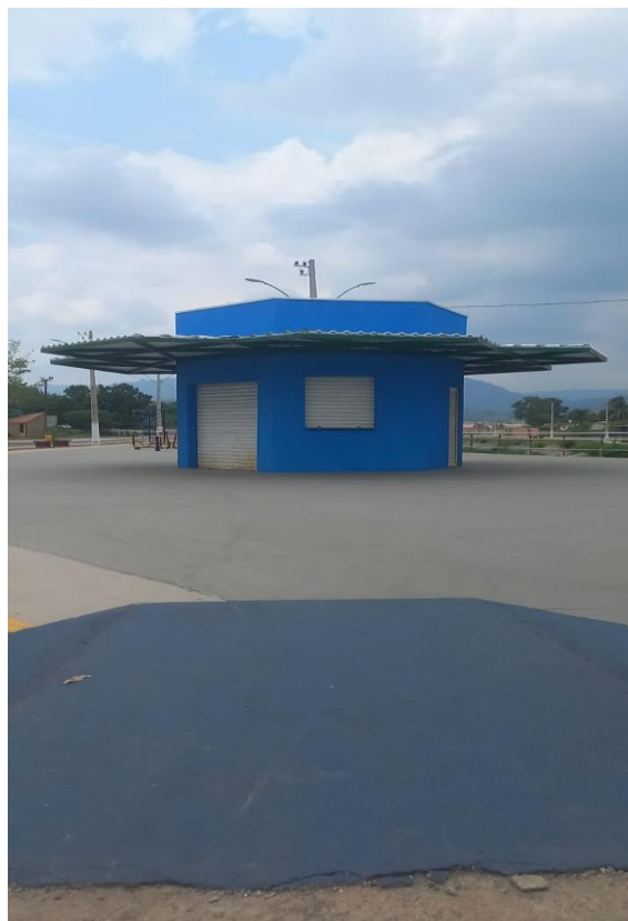
Foto 01: Imagem do quiosque localizado na Rua Beira Rio, esquina com rua Rio de Janeiro – Bairro Rio Verde. Fonte: PROSAP.
