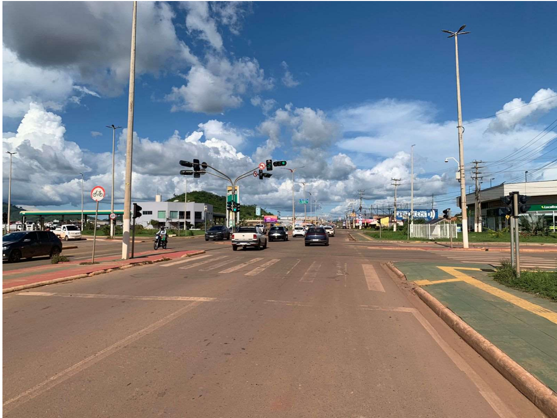
Figura 1 – ATSMSX20229- PA 275, km 60,1
