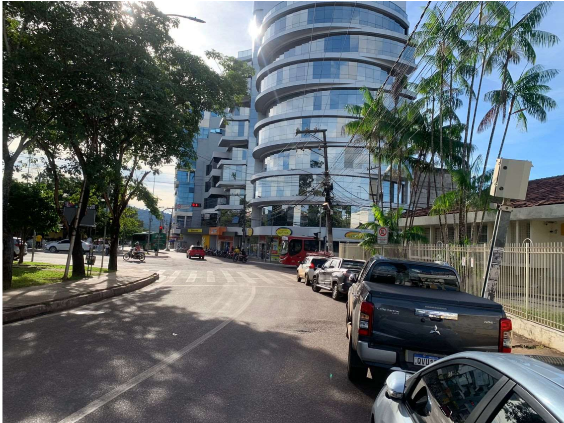
Figura 1 – ATSMSX20206- Rua E x Rua 10
