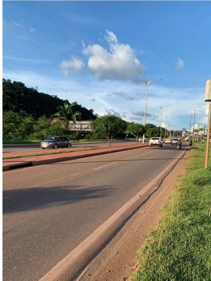
Figura 1 – ATSMSX60180- Rodovia PA 275, Km 60,8
