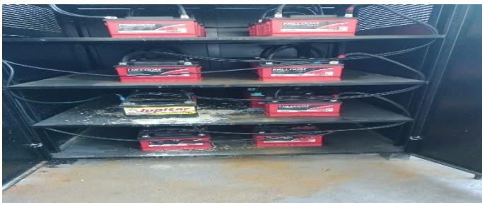
Banco de baterias do nobreak que atende setores críticos UCI,UTI.
