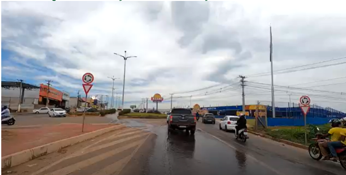
Figura 76 - Sinalização vertical na interseção Av. Liberdade x Av. A
