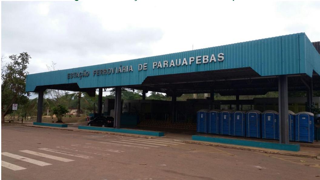
Figura 143 – Estação Ferroviária de Parauapebas
