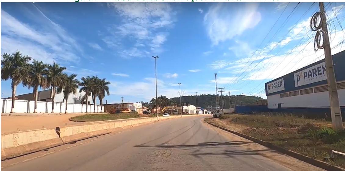
Figura 77 - Ausência de sinalização horizontal - PA-160
