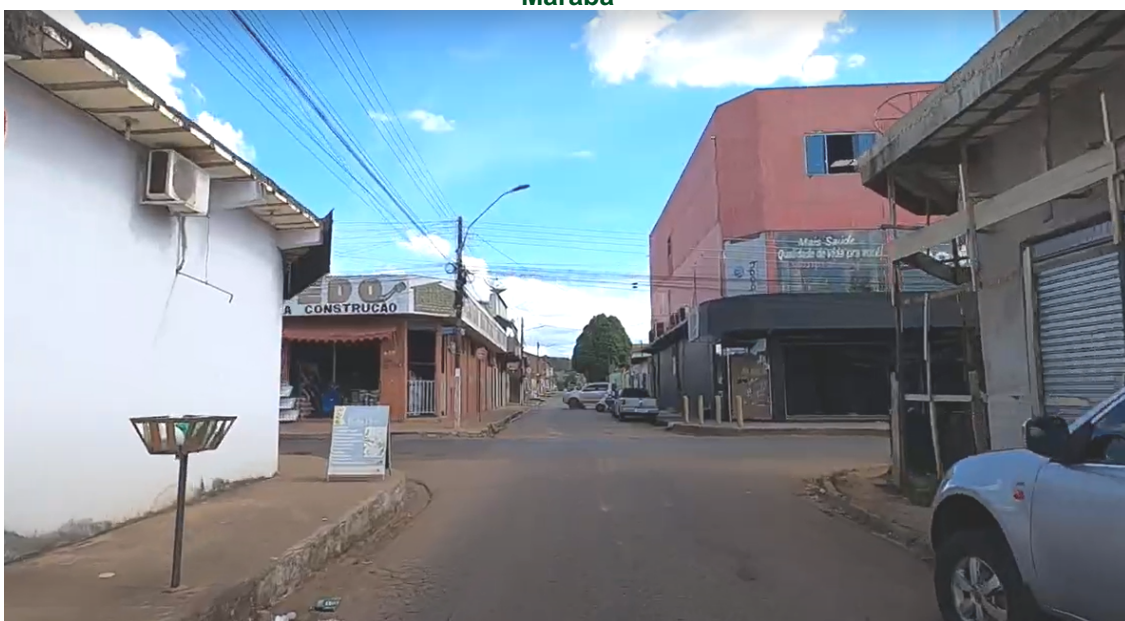
Figura 82 - Ausência de sinalização de trânsito - interseção Rua Cláudio Coutinho x Av. Marabá
