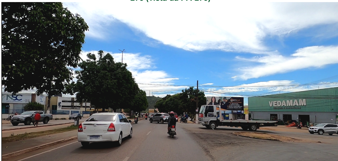
Figura 81 - Sinalização desgastada ou insuficiente na interseção Av. Pres. Kennedy x PA-275 (vista da PA-275)
