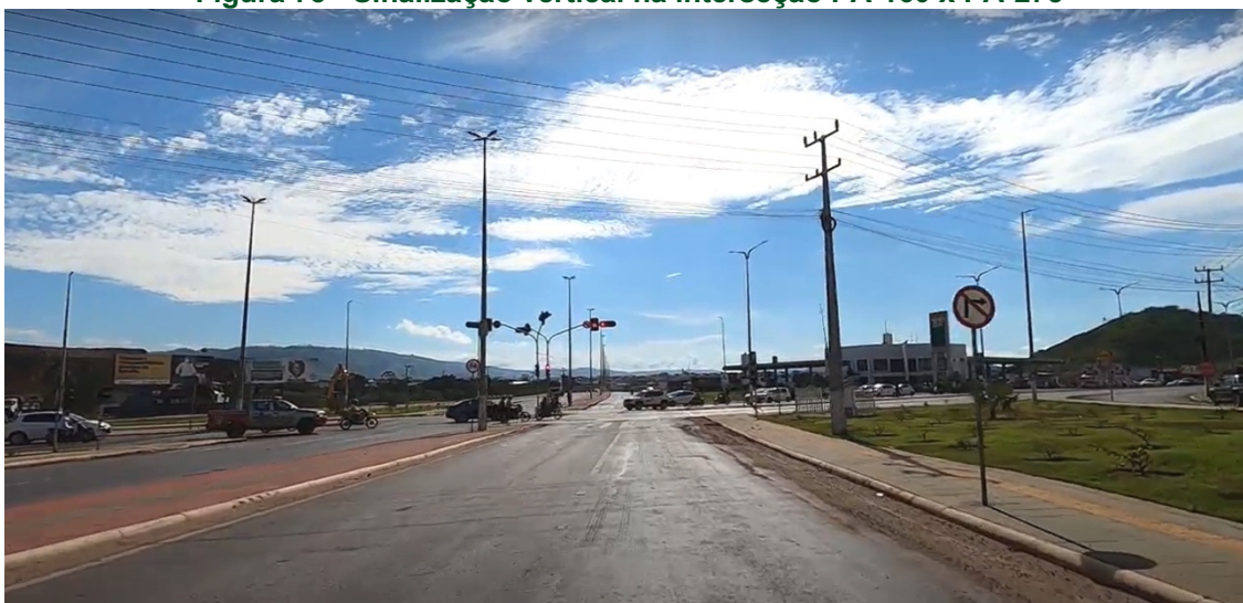
Figura 75 - Sinalização vertical na interseção PA-160 x PA-275
