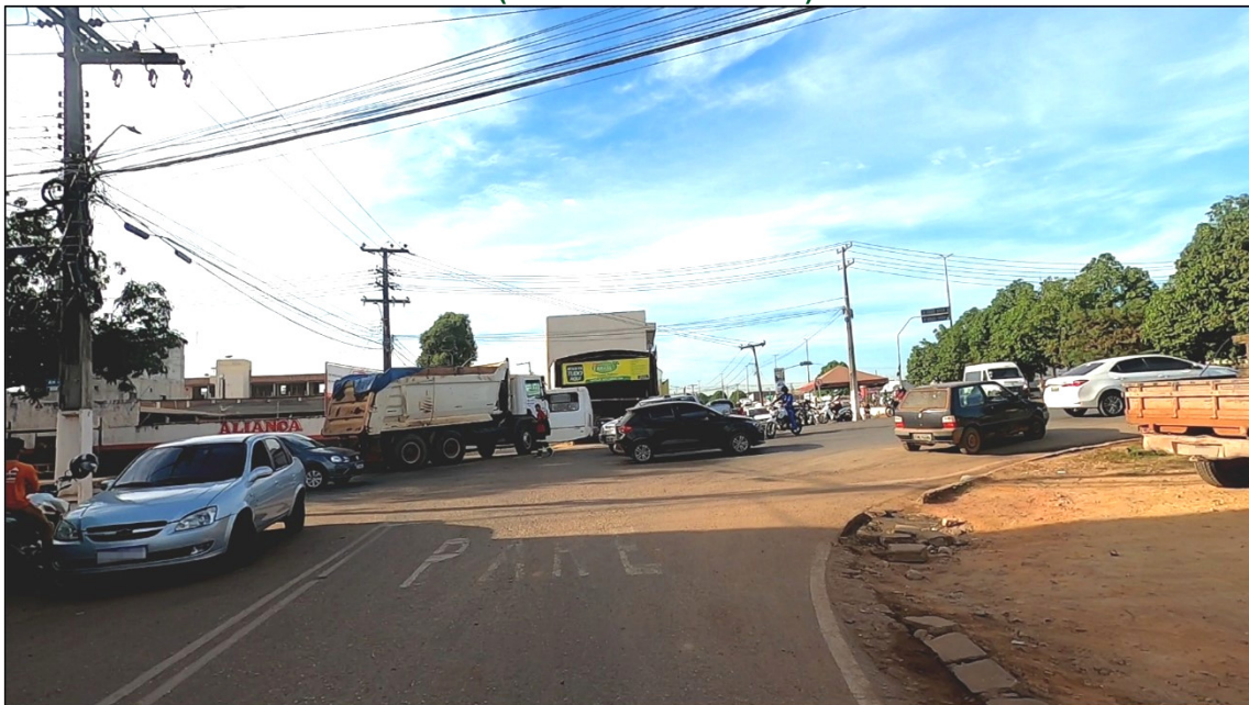
Figura 80 - Sinalização desgastada ou insuficiente na interseção Av. Pres. Kennedy x PA-275 (vista da Rua Rio Azul)
